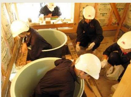
災害時浴室棟の建設工事の様子
