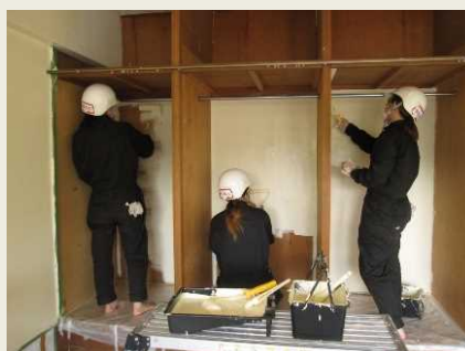
学生寮のリフォーム工事の様子
